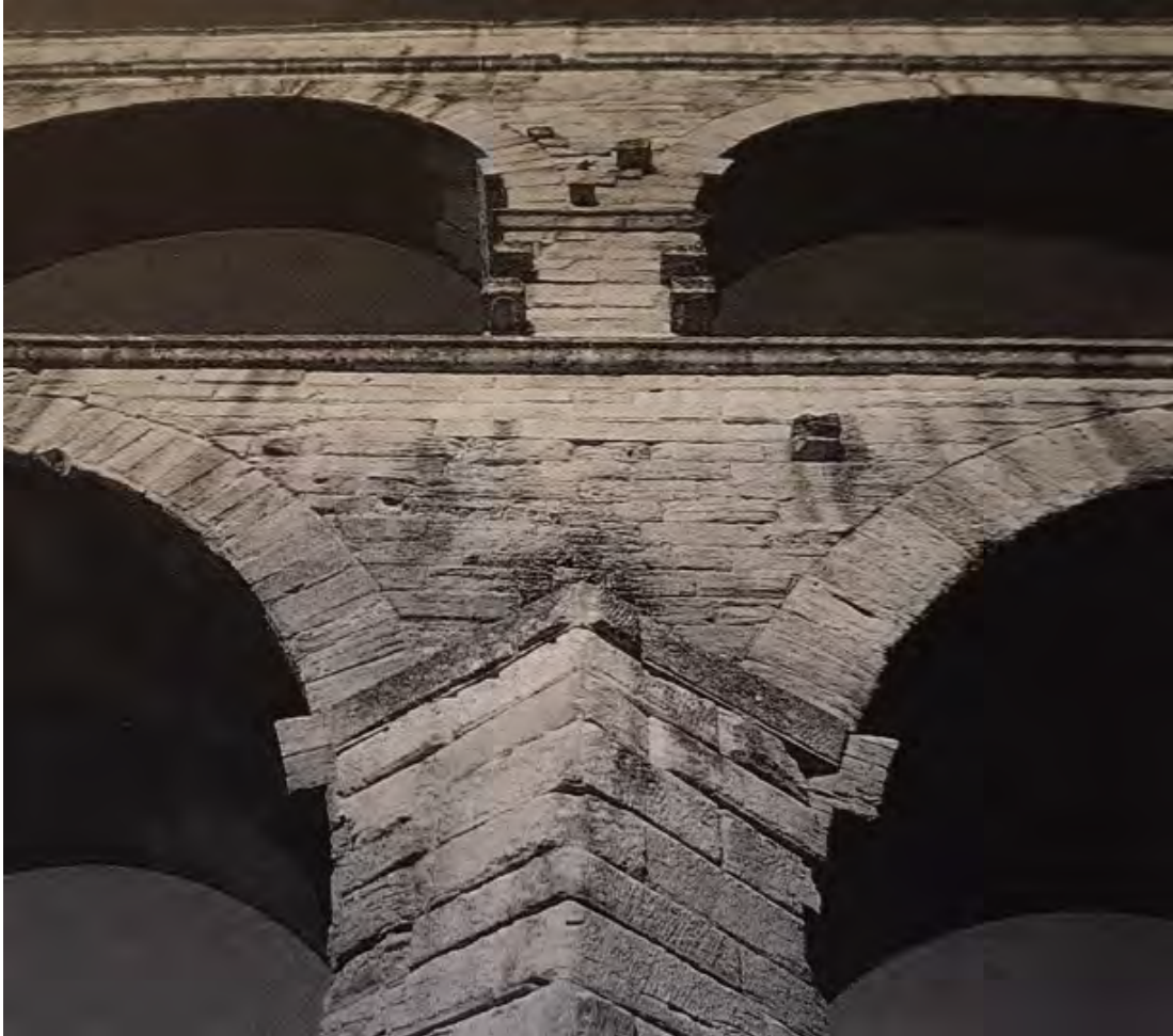
13. Les arches du deuxième étage du Pont du Gard, La vue montre les saillies d'appui des cintres et les trois rangs parallèles des claveaux.
