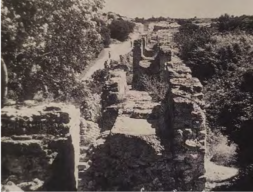
6. L'aqueduc d'Arles à Fontvieille. Le vallon des Arcs était franchi par deux ponts-aqueducs. A l'ouest (à droite sur le cliché), l'un conduisait les eaux des Aipilles jusqu'Arles. À l'est, un second ouvrage alimentait les seize moulins de Barbegal.
