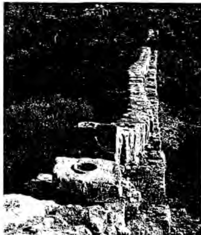
7. Patara sifone formato da una condotta costituita da blocchi di pietra (foto: K. Grewe, Bonn)
